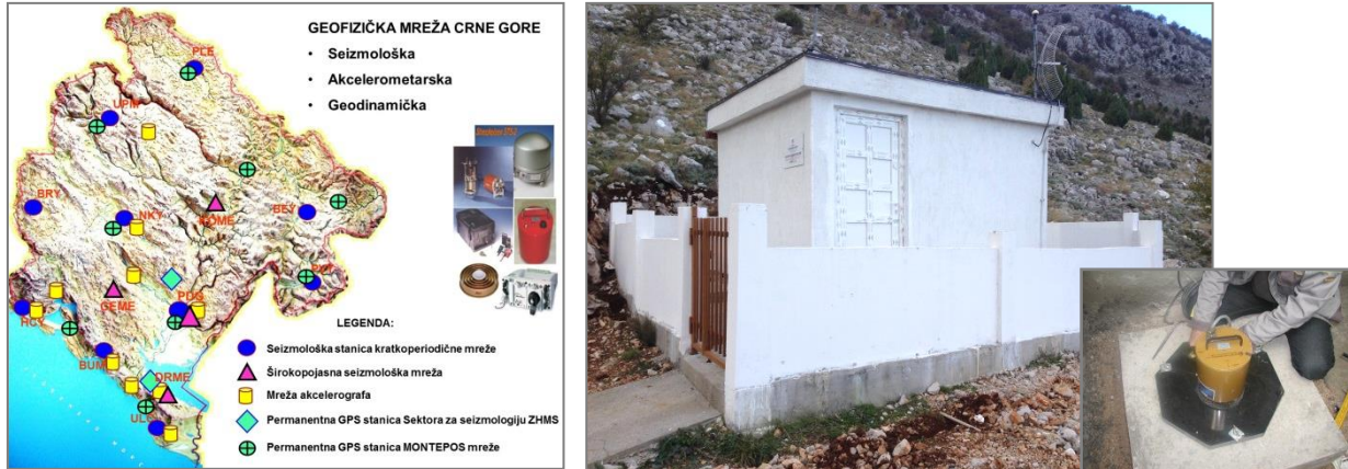
Struktura Mreže geofizičkih stanica Crne Gore (seizmološka, akceleroGRAFska i permanentna GPS) /lijevo/, primjer izgleda novog objekta automatske seizmološke stanice (selo Dračevica na Skadarskom jezeru) /u sredini/ i proces instaliranja seizmičkog senzora na piadestalu u dubokoj šahti ispod tog objekta (desno).
